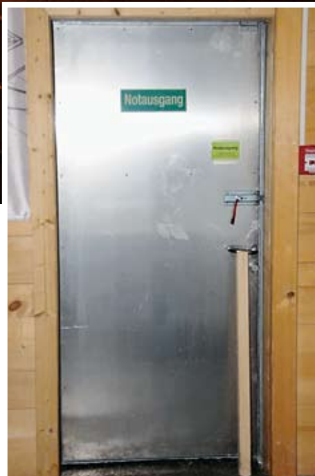
Zielkonflikt Nummer 1: Einbruch verhindert, Fluchtweg verriegelt. Dieses Sujet entdeckte ein Safety-Plus-Leser.
